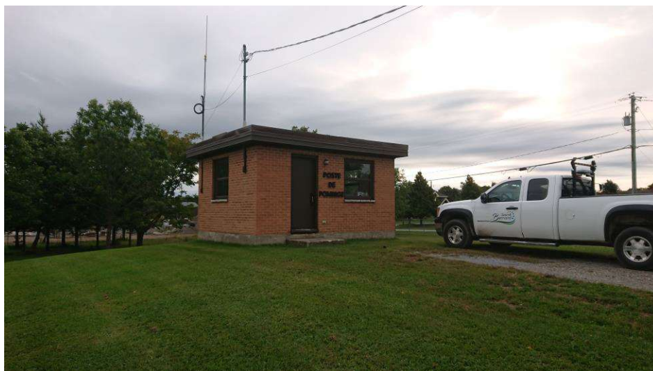
Vue de la station de pompage
