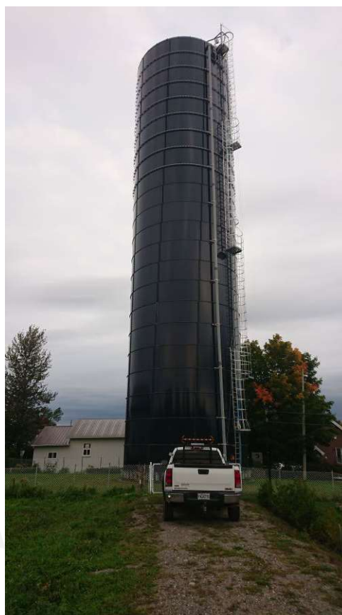
Vue du réservoir
