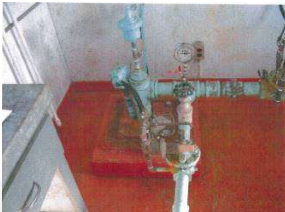
Vue de la tête du puits P-1. L'aménagement du puits P-2 est identique
