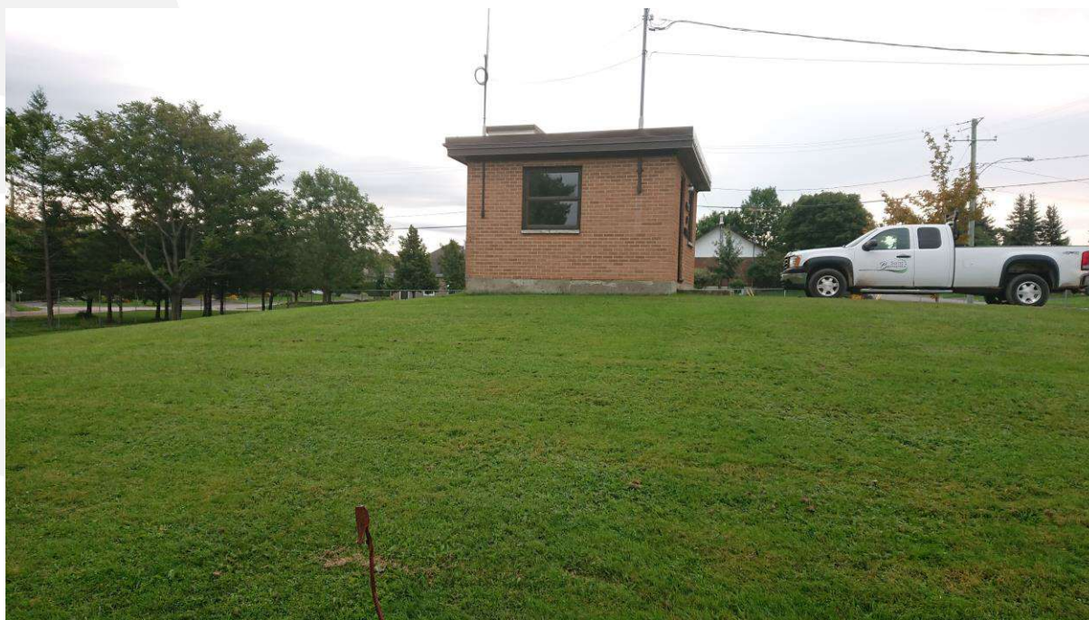
Vue du bâtiment de service qui abrite les puits P-1 et P-2 et son environnement immédiat
