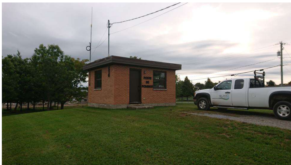
Vue de la station de pompage
